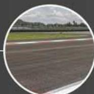
Dibuat menggunakan teknologi aspal Stone Mastic Asphalt (SMA)
